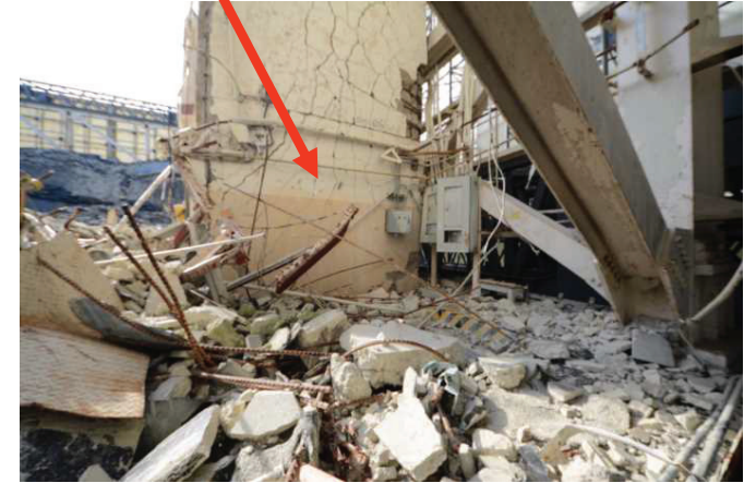
⑨北西部の状況
