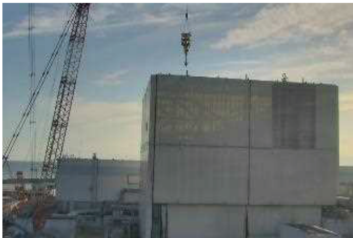
撤去装置吊り込み状況
