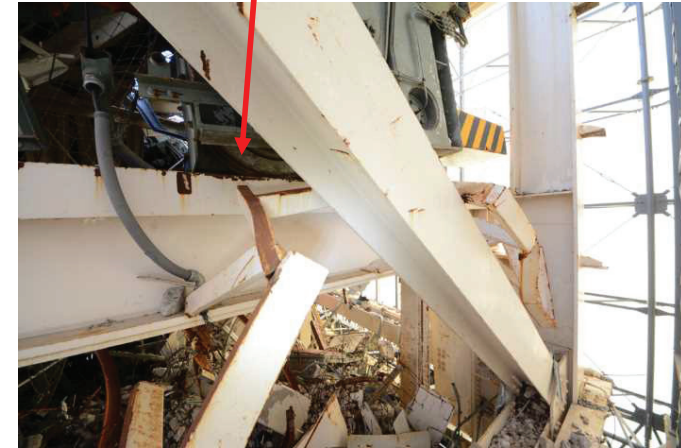
⑱天井クレーン南側ガーダ端部
