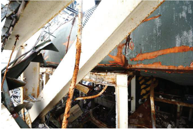
①天井クレーンガーダ(南側)
