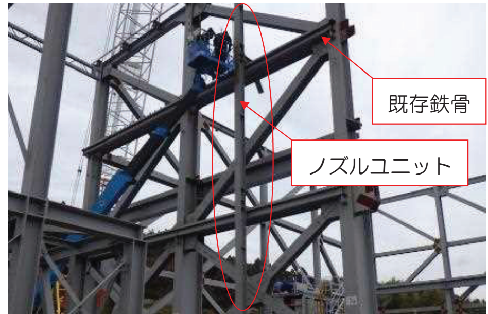
ノズルユニット取付訓練写真（構外ヤード）
