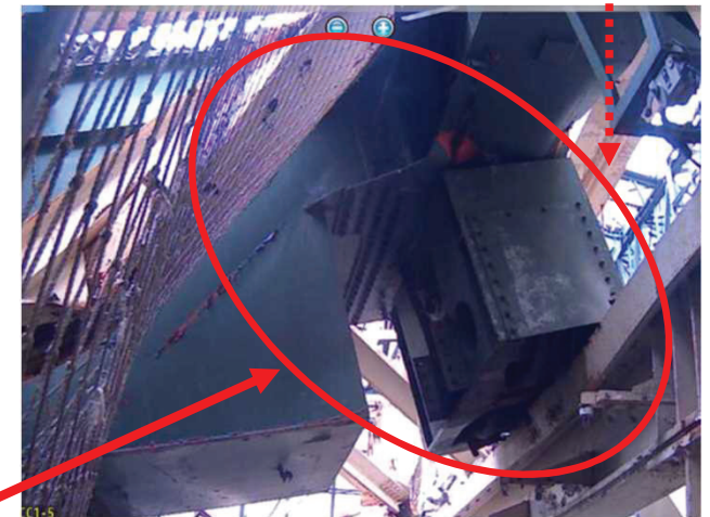
写真4 天井クレーン北側ガーダ東側外観
