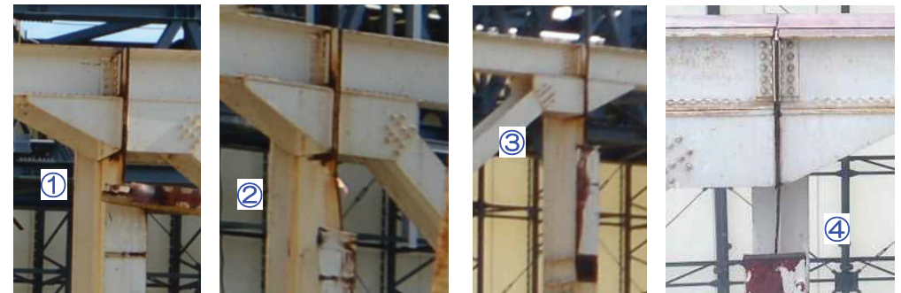
①フランジ外れ ②フランジ外れ ③フランジ外れ ④フランジ外れ
