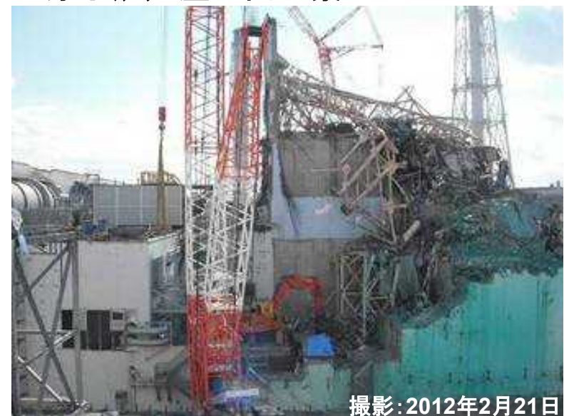
■原子炉建屋北面全景
