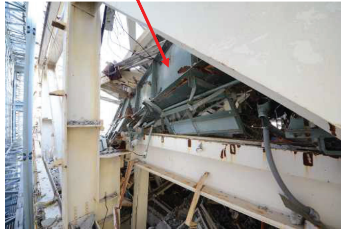
⑰天井クレーン西側サドル
