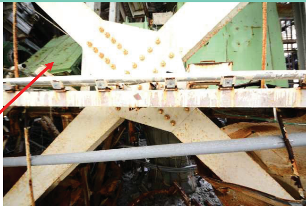
⑤南側空調機及び空調機架台
