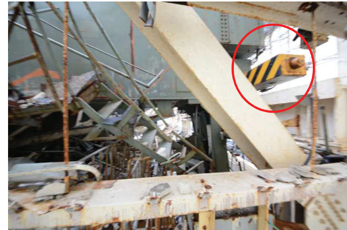
③天井クレーンガーダ(南側)東端部
