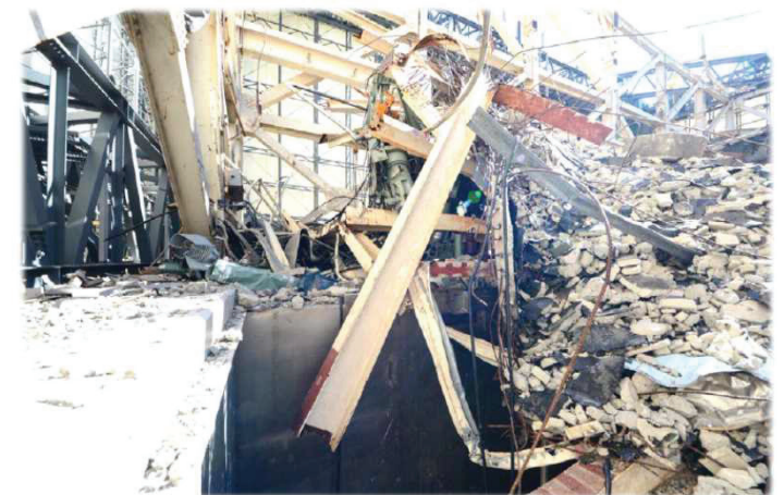
⑪DSP開口部付近状況
