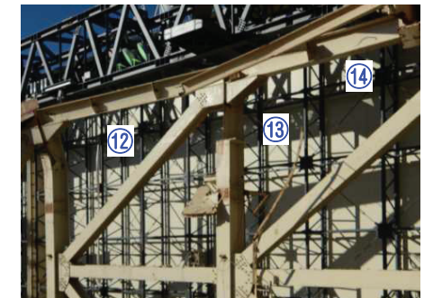
⑫ 梁変形、⑬ 柱フランジ外れ、 ⑭ 梁フランジ変形
