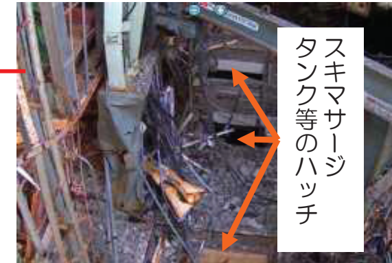
写真4 スキマサージタンク 等のハッチ開放
