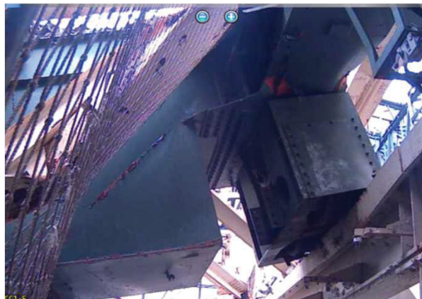
⑩ 天井クレーン北側ガーダ東側脚部
