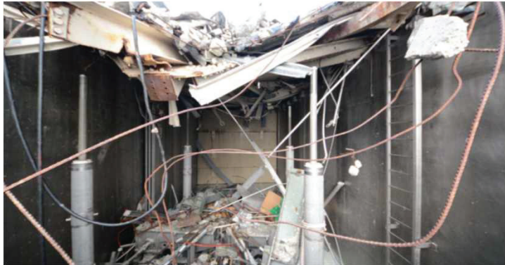
写真1 DSP内のガレキ
