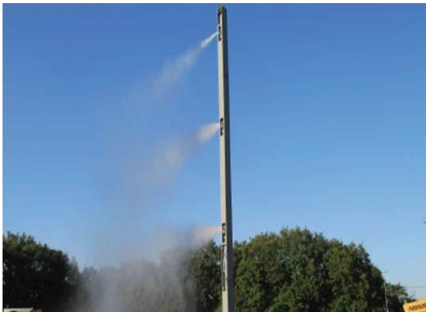
散水設備モックアップ状況写真
