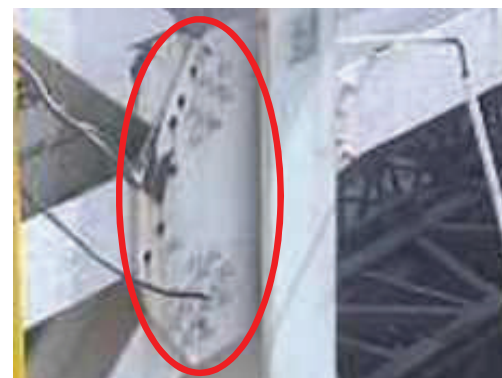
梁・ブレース接合部ボルトなし
