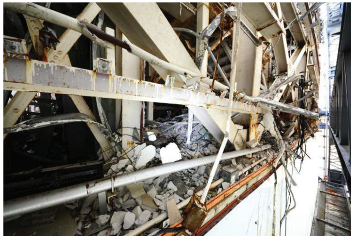
④南側既存鉄骨とカバー鉄骨間
