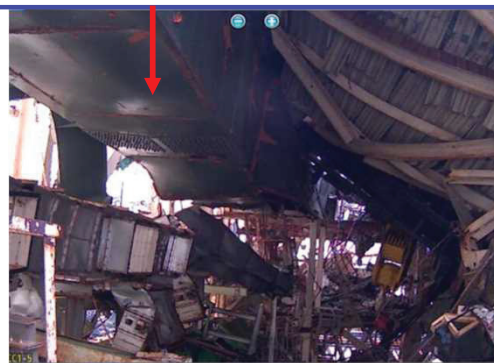
⑬ 天井クレーン南側ガーダ部
