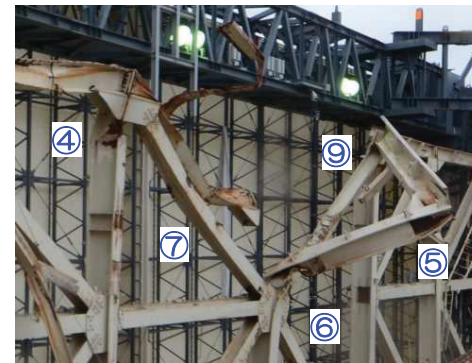
④ 柱フランジ外れ ⑤ 梁、柱外れ、 ⑥ 梁外れ、⑦ ブレース変形、 ⑧ 梁接合部ボルトなし ⑨ ブレース変形、 ⑮ ブレースフランジ変形
