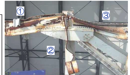
①、③ 梁変形、② 柱フランジ外れ
