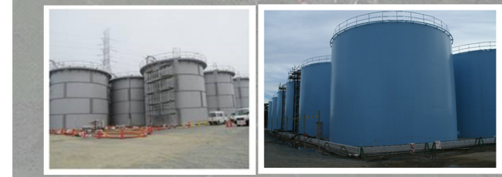
タンクの設置状況
