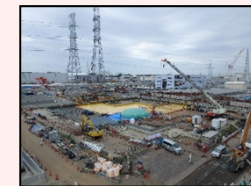
解体後の様子
