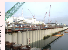
海側遮水壁 鋼管矢板打設完了状況
