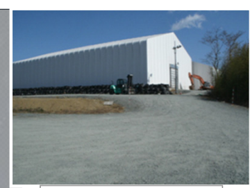
瓦礫保管テント
