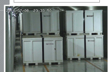
固体廃棄物貯蔵庫
