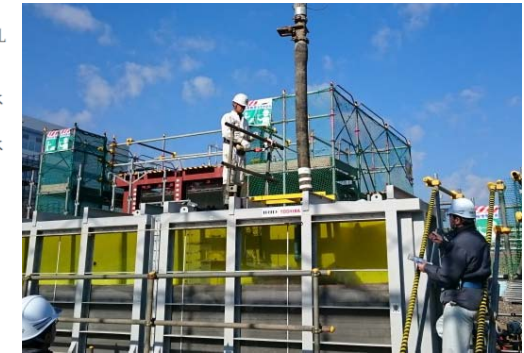
図4 大型ダウンカマ試験の打設状況
