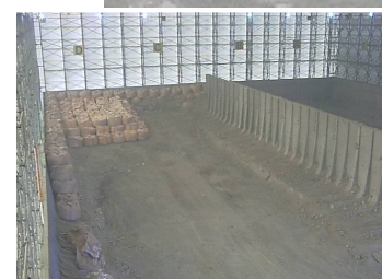
瓦礫保管 テント内
