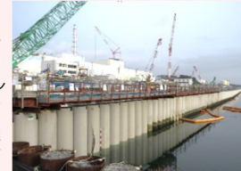
海側遮水壁 鋼管矢板打設完了状況
