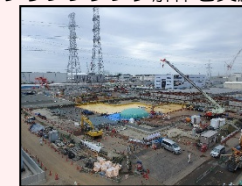
H1東エリア解体後の様子
