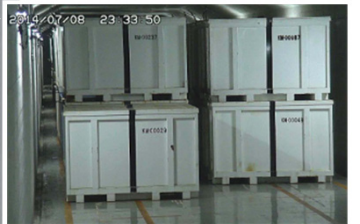
固体廃棄物貯蔵庫
