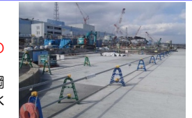
(海側遮水壁埋立部舗装状況)
