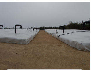
伐採木一時保管槽
