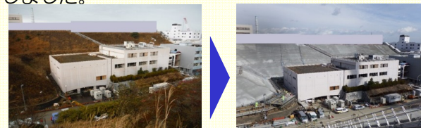
<フェーシング工事の状況>
