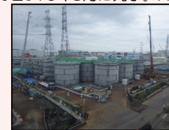
H1東エリア解体開始時の様子
