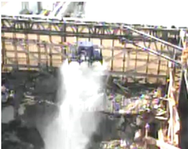
飛散防止剤散布の作業状況写真
