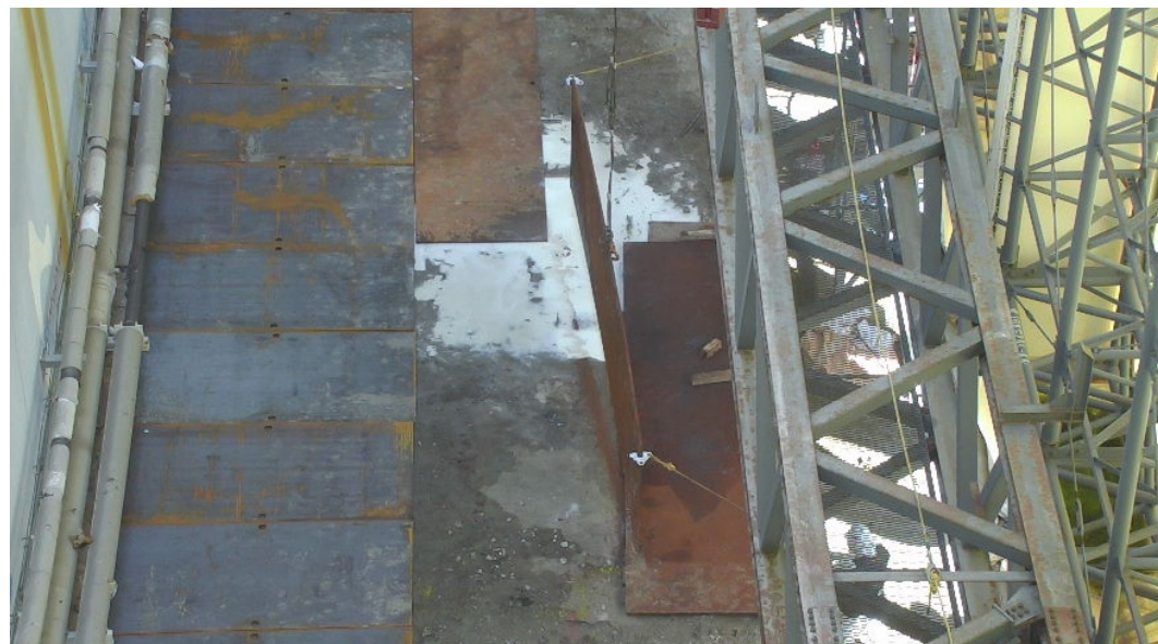
散水ノズルまでの配管設置等の作業状況写真 (敷鉄板整備)
