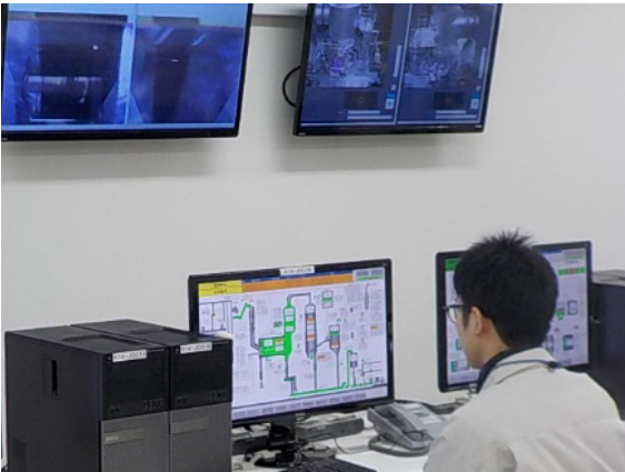
制御室 試験作業状況
