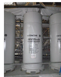
サブドレン等浄化 (吸着塔)
