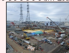
H1東エリア解体後の様子
