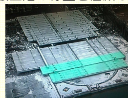
<遮へい体の設置状況>
