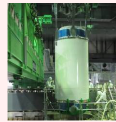
燃料取り出し状況
