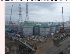
H1東エリア解体開始時の様子
