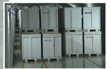
固体廃棄物貯蔵庫
