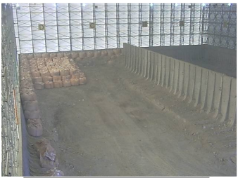
瓦礫保管 テント内
