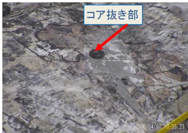
D部 オペフロ北側コア抜き状況
