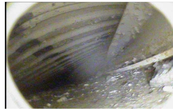
D部 オペフロ北側コア抜き部(内部)
