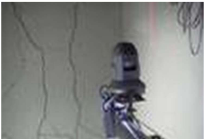
壁面のひび割れ状況
