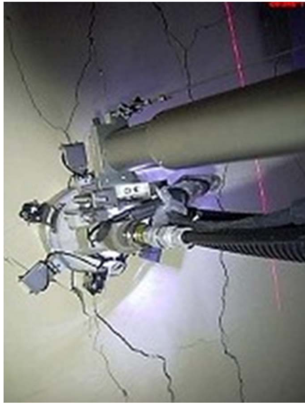
ドライアイスブラスト除染状況
