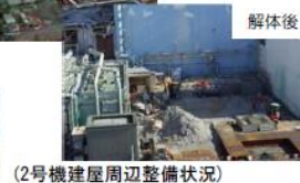
(2号機建屋周辺整備状況)
