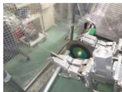
グラインダーによる鋼材の切断状況
