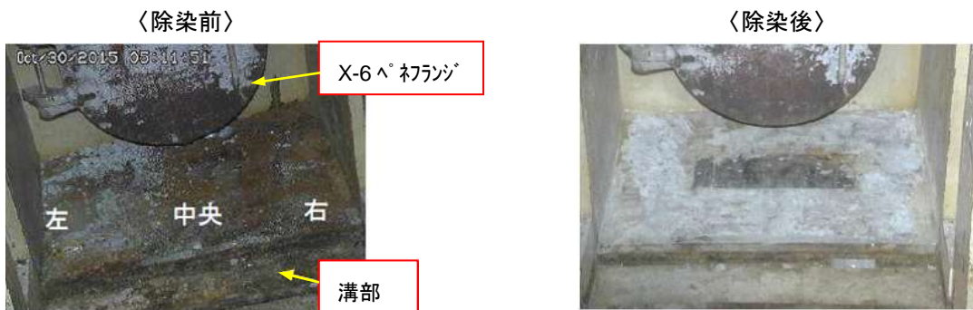
図 4.3.2-19 2号機 X-6 ペネ周辺除染状況 (東京電力提供)
