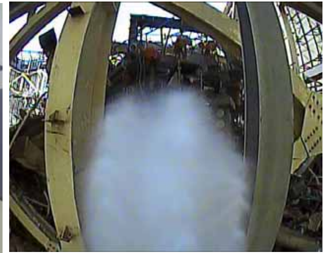
飛散防止剤散布状況
