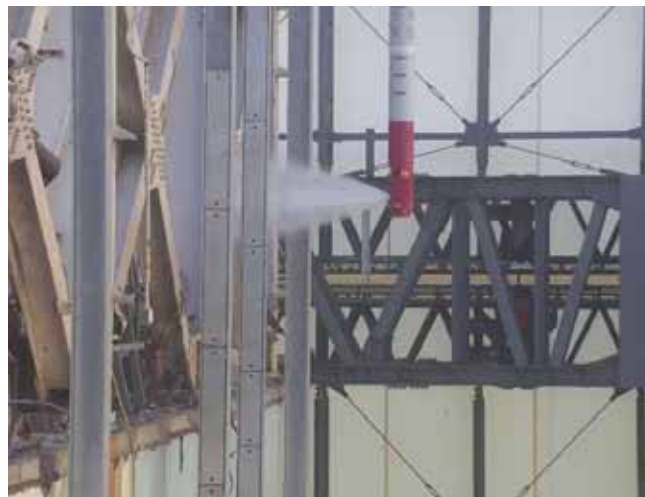
飛散防止剤散布状況（東面）
