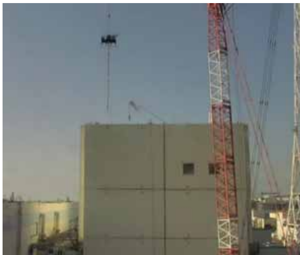
飛散防止剤散布装置吊り状況
