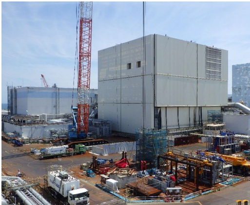
全景(北西面) 撮影：H28.8.11
