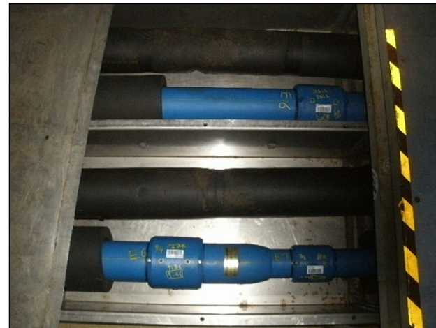
PE管 (100A) 施工状況 <4号機タービン建屋内>
