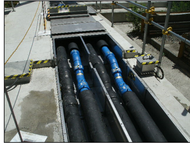
PE管 (100A) 施工状況<屋外>
