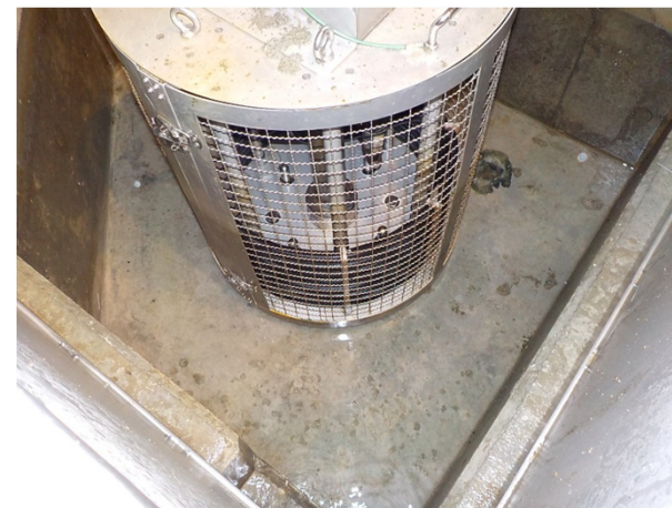
図4 清掃後の状況(7/7)
