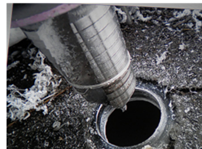
ピット内点検口削孔状況 (9/6実施)
