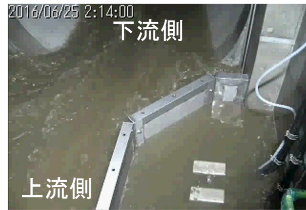
図2 降雨時の状況(6/25)水位が高く、改造前の堰は完全に水没。
