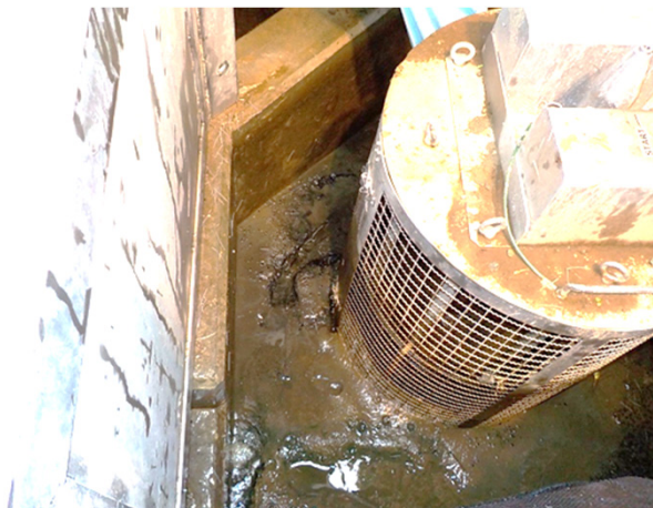
図3 清掃前の状況(7/7) 土砂がヘドロ状に滞積
