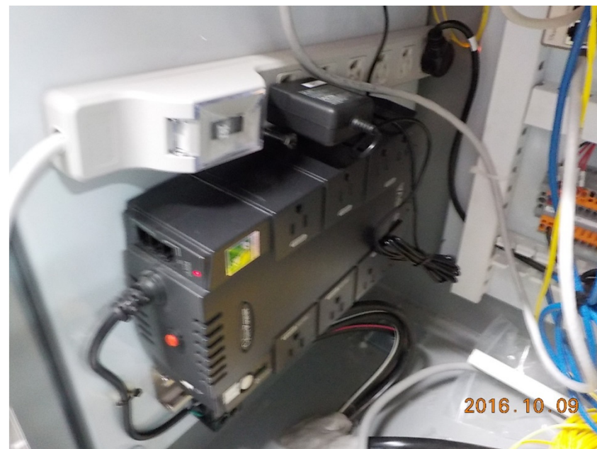
応急対策としてコンセント 電源により電源供給開始
