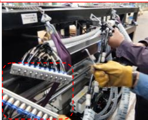
操作ケーブルの接続
