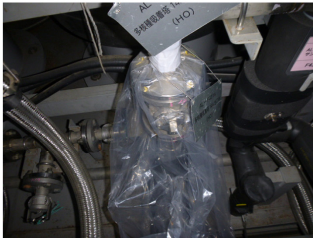
滴下発生箇所 (袋養生実施後)
