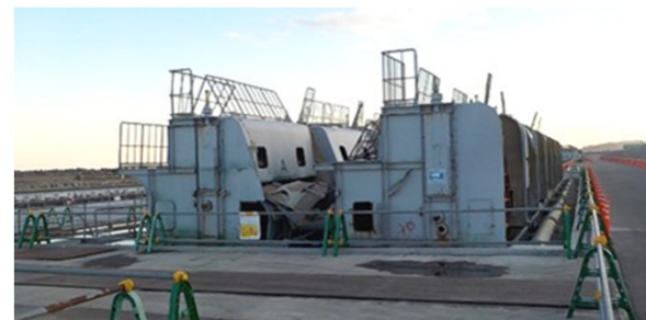
【集水タンク増設エリア写真】
