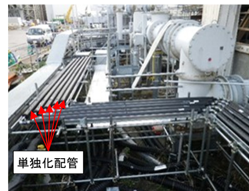
【中継タンクNo.4 北側】
