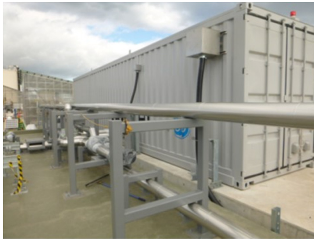
【地下水ドレン前処理装置の設置状況（4m盤）】
