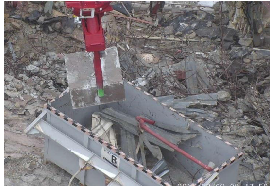
干渉ガレキ撤去 撮影：H29.2.9
