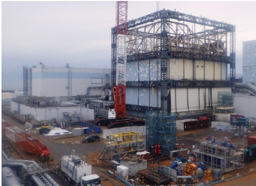
全景(北西面) 撮影：H29.2.20
