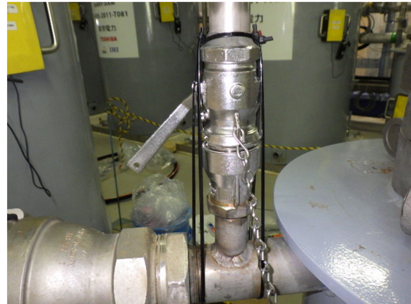
交換後の耐圧ホースの継ぎ手部
