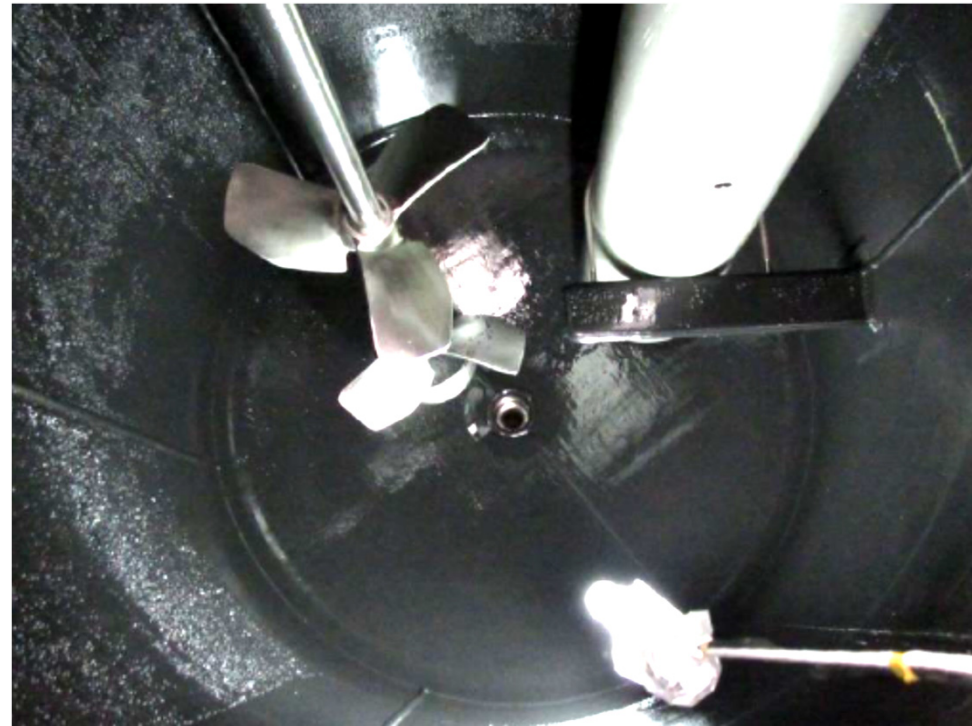
供給タンク(B)内面の状況 (H29.2) 【ライニングに剥離なし】
