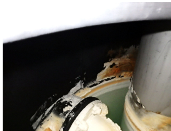
共沈タンク(A)内面の状況 (H29.2) 【ライニングに剥離なし】
