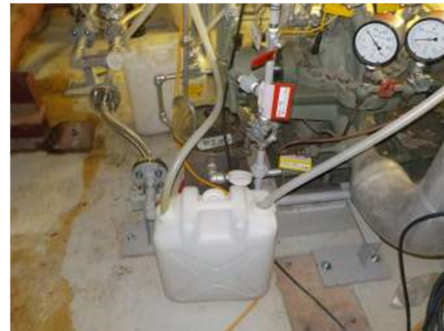
軸受冷却水配管ベント後状況
