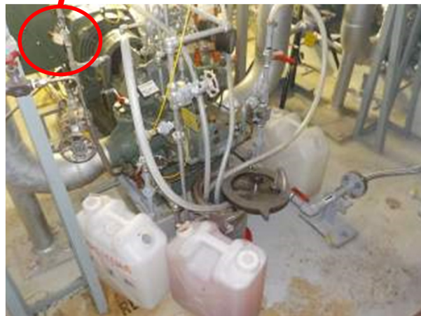
軸受冷却水配管ベント状況
