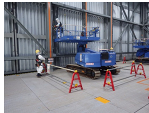
写真② 前室壁隙間塞ぎ作業状況
