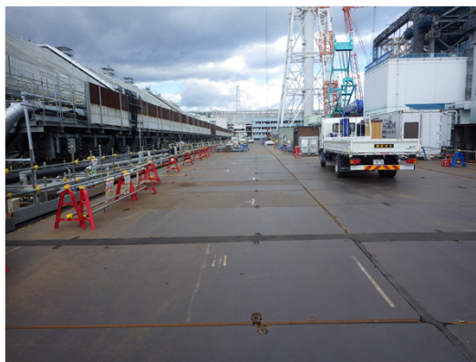
写真① 西側路盤整備完了
