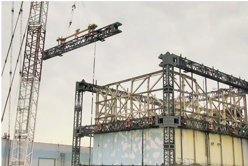
上段北梁取り外し (3/31)
