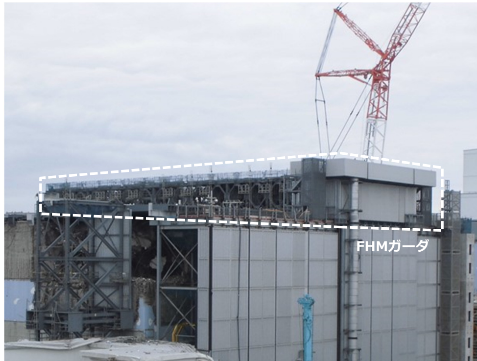
FHMガーダ建方状況（撮影日2017年5月10日）
