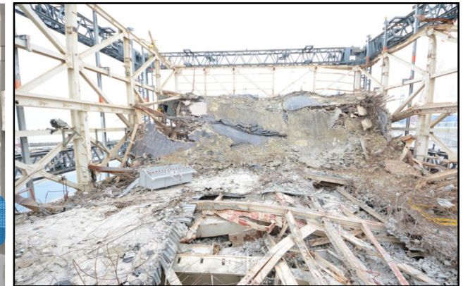
崩落屋根状況
