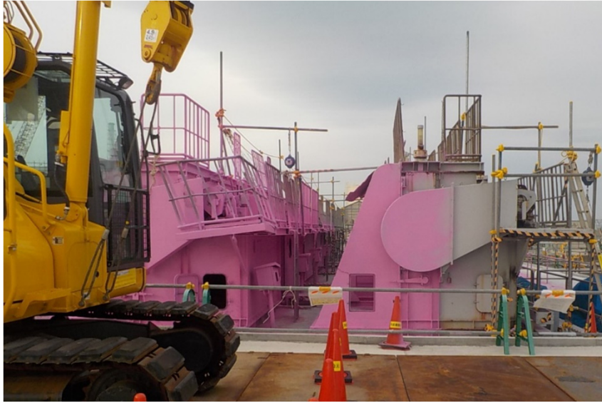
集水タンク増設（2号機除塵機撤去前）
