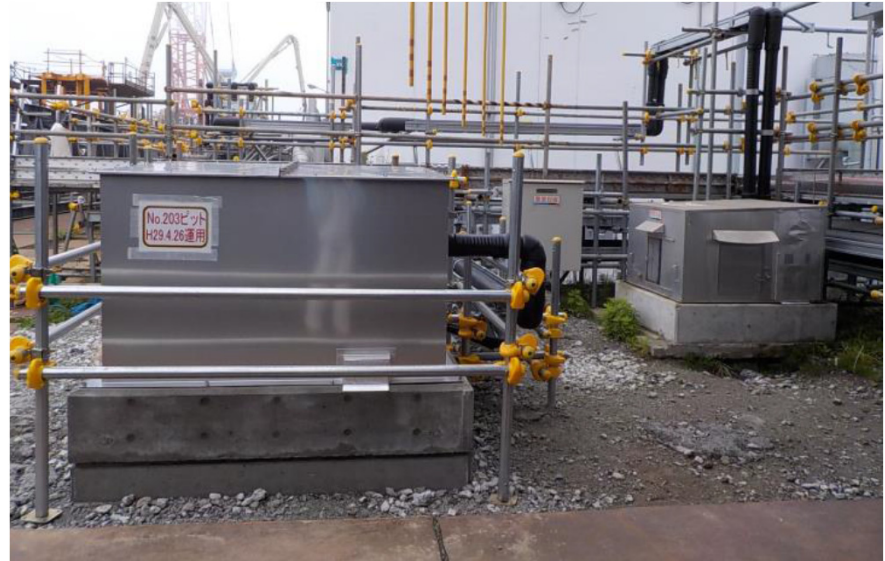
新設ピット増強（順次施工中）
