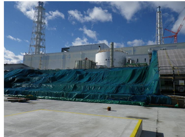
7.5m盤法面シート架け
