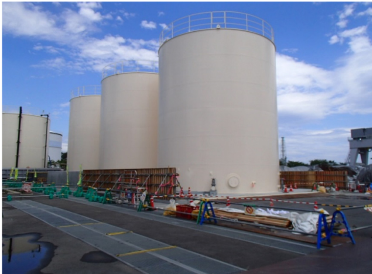
サンプルタンク増設
