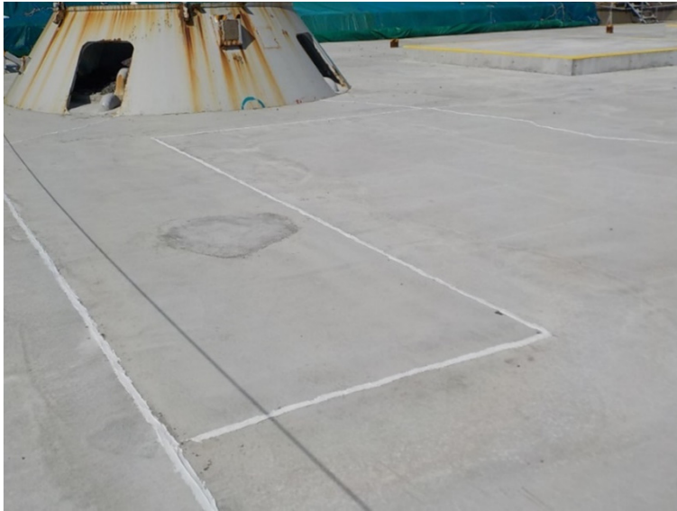
4m盤フェーシング継手止水
