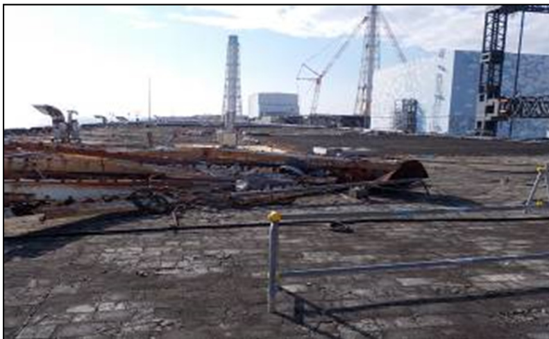
【施工前】1号機T/B屋上
