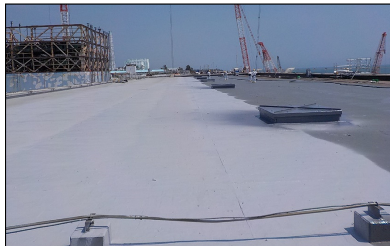
【現況】2号機T/B屋上
