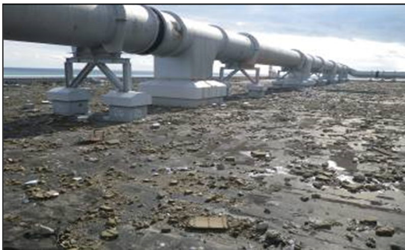
【施工前】4号機T/B屋上
