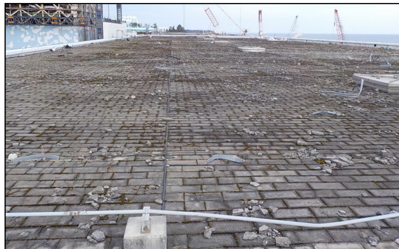
【施工前】2号機T/B屋上
