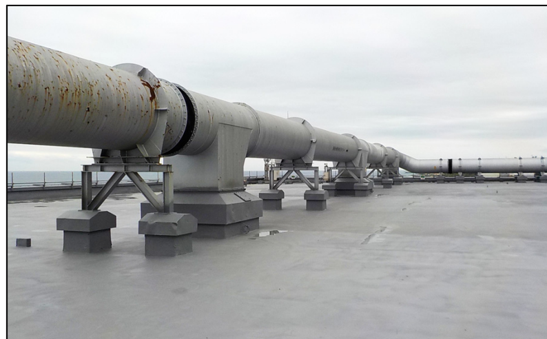
【現況】4号機T/B屋上
