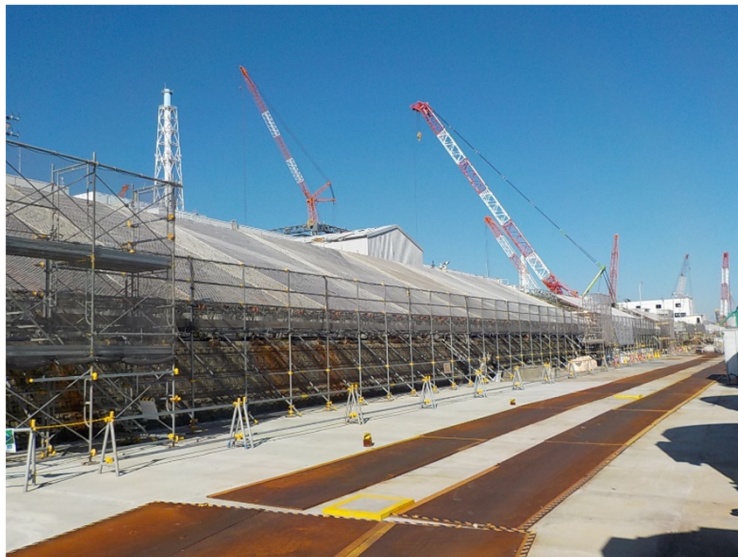
7.5m盤法面屋根架け
