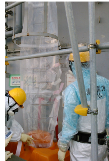
仮設タンク設置
