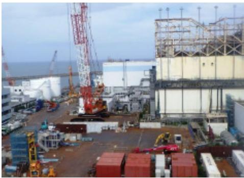
工事エリア全景 撮影：H29.6.26
