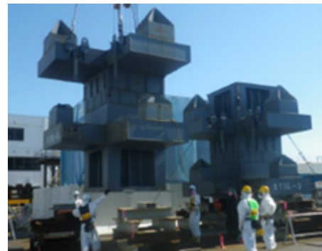
カバー柱改造 撮影：H29.6.17
