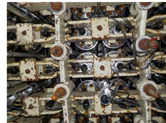
(参考) 5号機のCRDハウジング およびCRDハウジング支持金具
