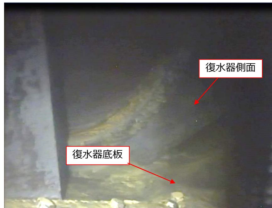
水抜き後の復水器底板の状況確認 (視線方向②)
