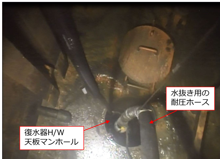
復水器H/W天板下部の水抜き作業 (視線方向①)
