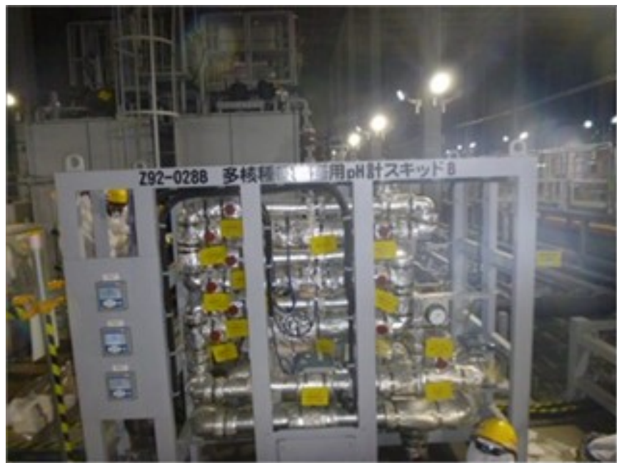
吸着塔用pHスキッド全景
