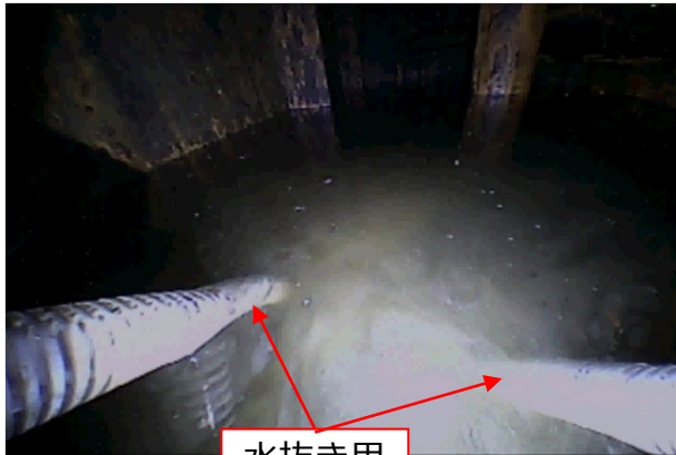
水抜き用のホース
