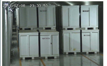
固体廃棄物貯蔵庫
