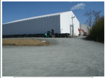
瓦礫保管テント
