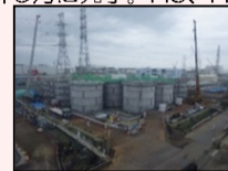
H1東エリア解体開始時の様子
