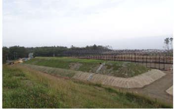
覆土式一時保管施設
