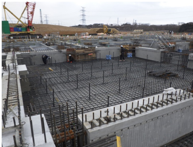
② マットスラブ配筋
