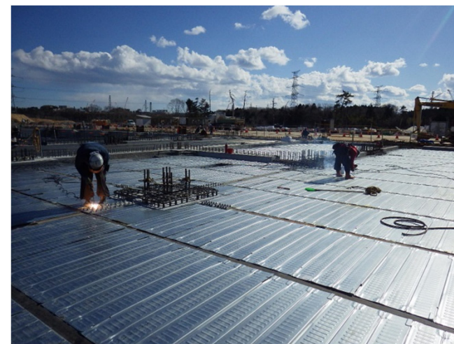
③ 1階床デッキ設置
