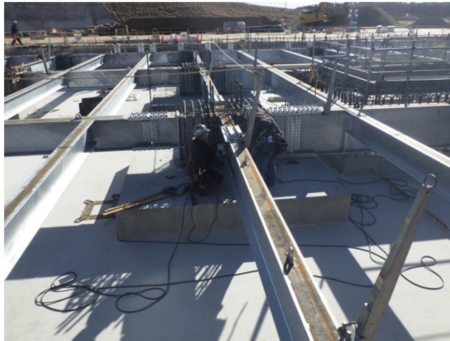
① 1階鉄骨梁設置
