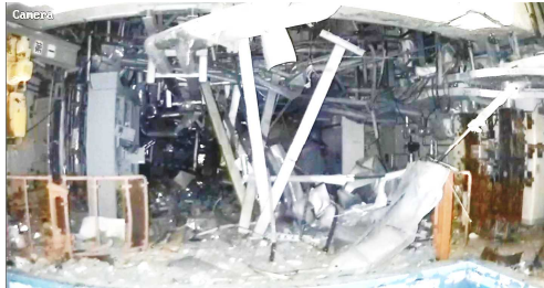
写真① (3階開口部から北向き)
