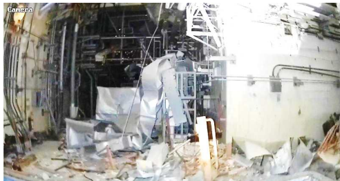
写真③ (2階開口部から北向き)
