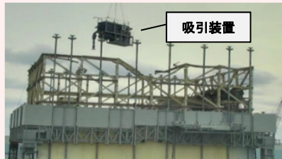
<進捗状況(1/22撮影)>
