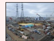
H1東エリア解体後の様子
