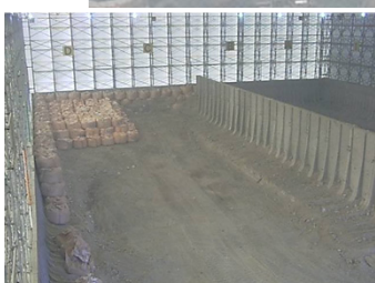
瓦礫保管 テント内
