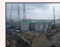
H1東エリア解体開始時の様子
