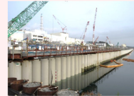
海側遮水壁 鋼管矢板打設完了状況
