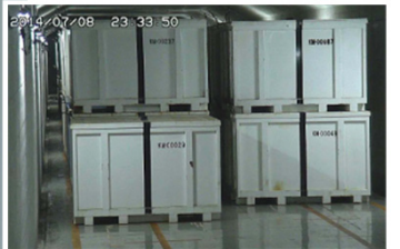
固体廃棄物貯蔵庫
