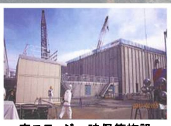
廃スラッジ一時保管施設
