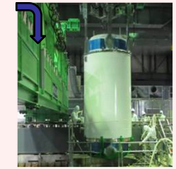
燃料取り出し状況
