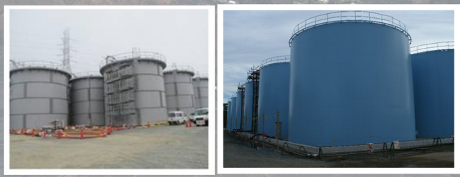
タンクの設置状況
