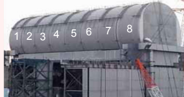
ドーム屋根設置状況 (2/21撮影)
