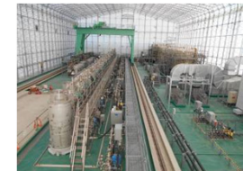
(高性能多核種除去設備)
