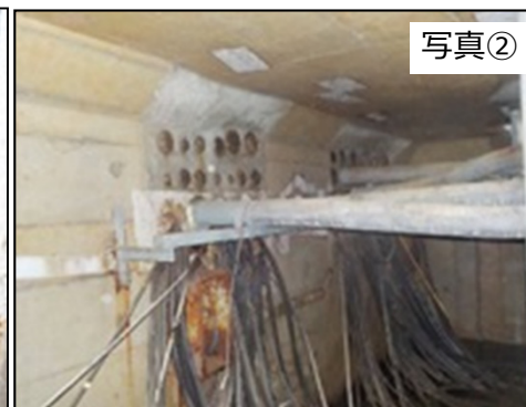
建屋貫通箇所の状況
