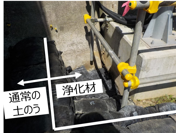
浄化材設置状況 (1)
