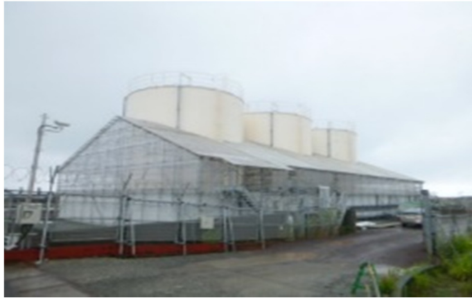
既設集水タンク
