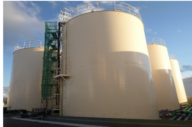
増設一時貯水タンク
