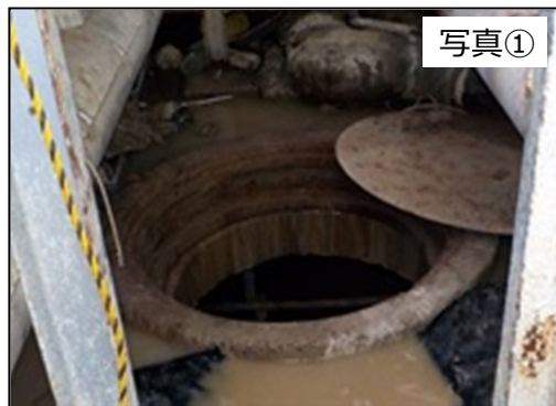
トレンチのマンホール
