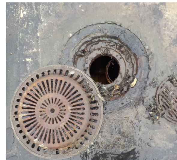
屋上ルーフトレン配管の損傷状況
