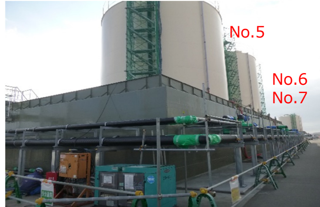
増設集水タンク
