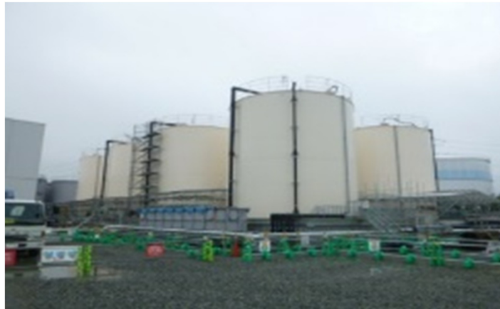
既設一時貯水タンク
