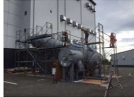
ベント管1/1スケール試験
