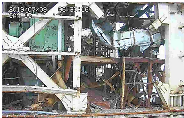
南側小ガレキ撤去前
