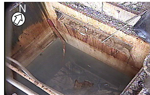
スキマサージタンク養生設置前
