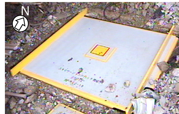
スキマサージタンク養生設置後
