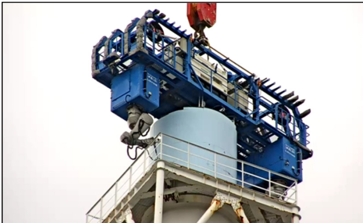
【写真①】筒身切断状況(10月8日)
