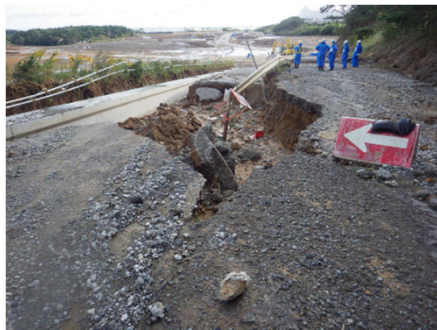
② 第二土捨場北構内道路
