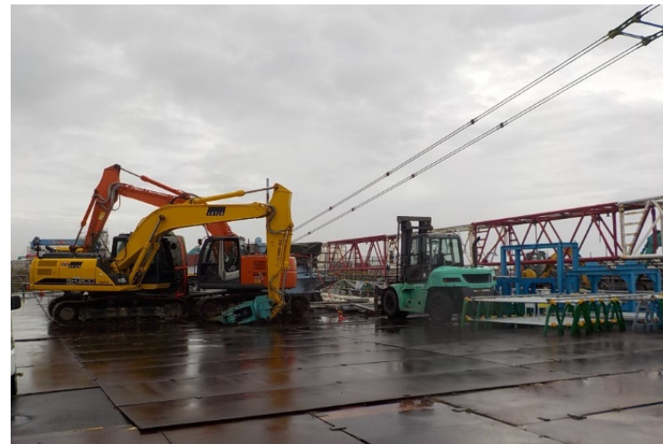
(350 t クレーン)
