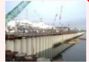
海側遮水壁 鋼管矢板打設完了状況
