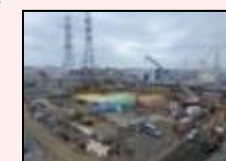
H1東エリア解体後の様子
