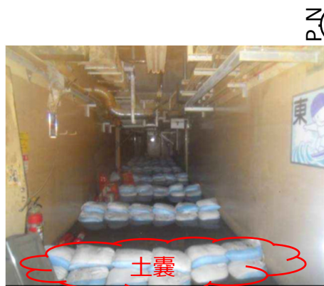
PMBの土嚢設置時の状態 ※震災直後に、PMBに貯留する滞留水中の放射性物質を吸着するため約16t投入
