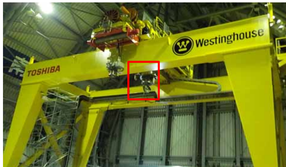
<クレーン全景>
