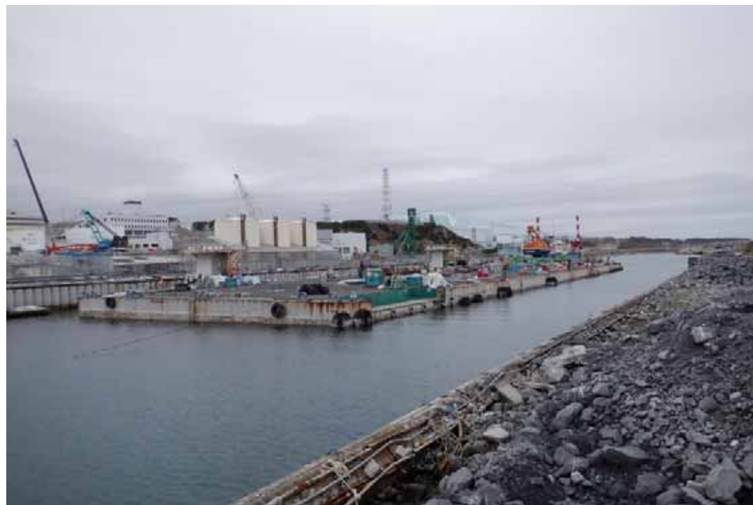
【仮着底後のメガフロートの様子】
