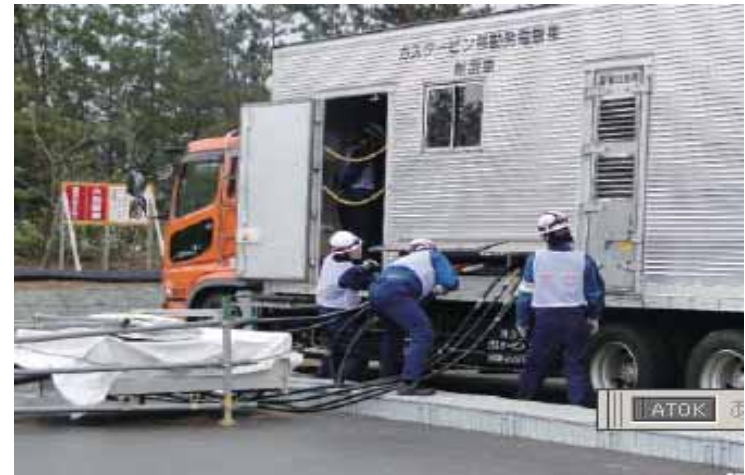
空冷式ガスタービン発電機車(4500kVA)
