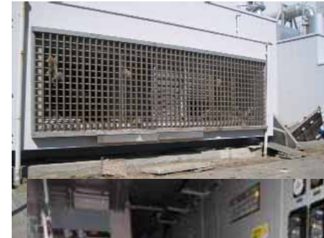
1号機非常用送風機室外側
