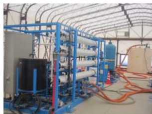
逆浸透膜装置
