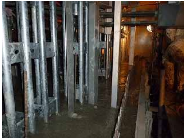
コンクリート打設状況 (H23.7.21撮影)
