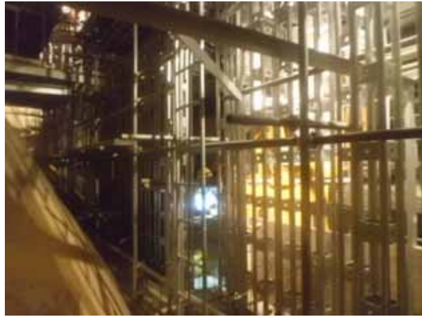
鋼製支柱設置状況 (H23.6.20撮影)
