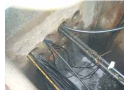
3号機取水口付近のピット内の流入状況
