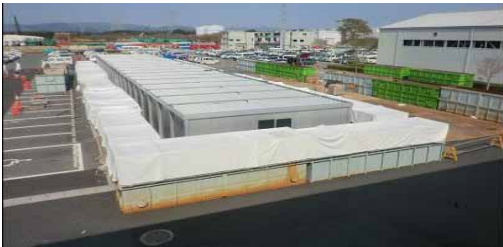
休憩施設（免震棟前）
