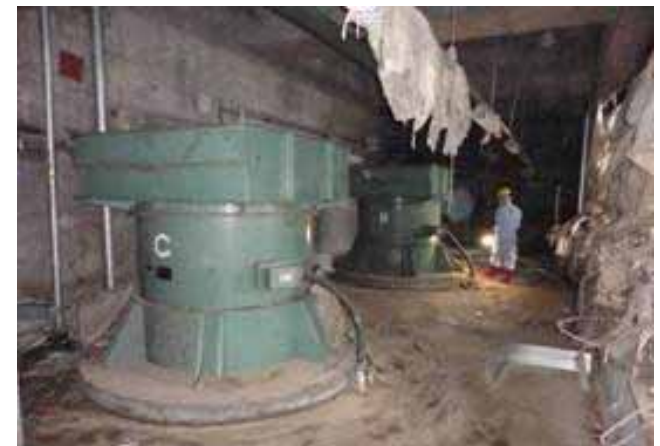
1号機非常用送風機室内側
