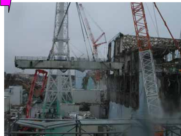
4号機天井クレーンガーダー撤去作業 H24.3.5
