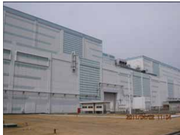
3 / 4号機タービン建屋は被害なし
