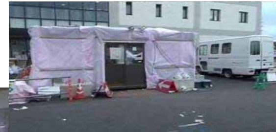
免震重要棟入口 (出入管理用ユニットハウス)
