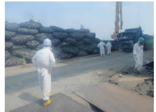
仮設防潮堤設置作業
