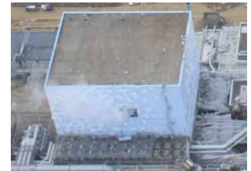
2号機 ブローアウトパネルの開放状況
