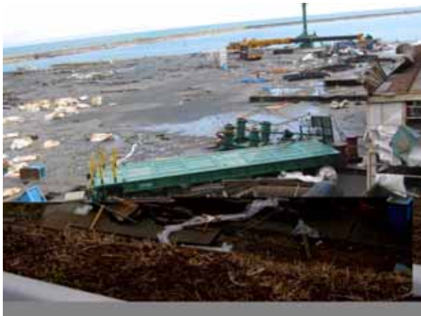
低い箇所の津波被害(物揚場)
