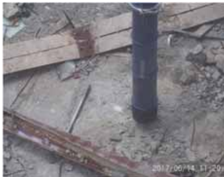
吸引機によるガレキ撤去の様子
