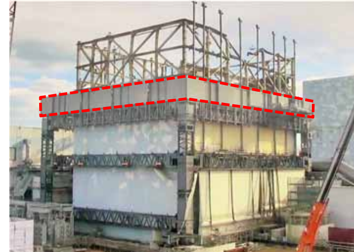
2017年12月19日：防風フェンス取り付け完了
