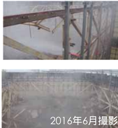
散水設備による散水状況
