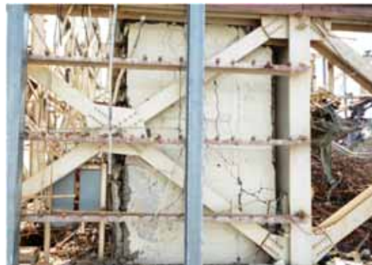
西面の壁状況
