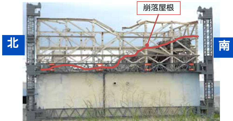
防風フェンス取付前の写真を使用
