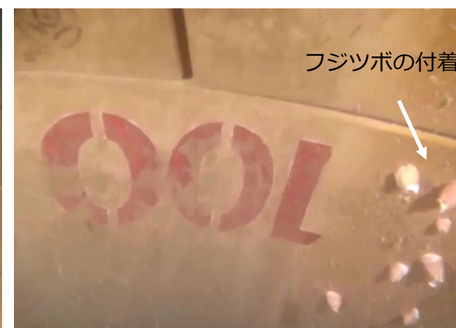
下流水槽から100m付近トンネル上面の状況
