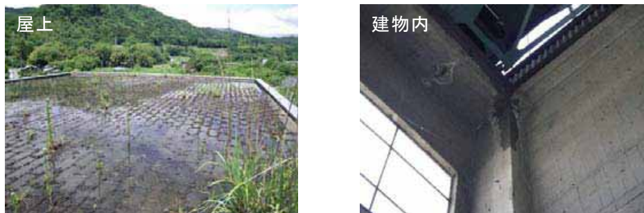
建物雨漏り例
