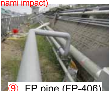
⑨ FP pipe (FP-406)
