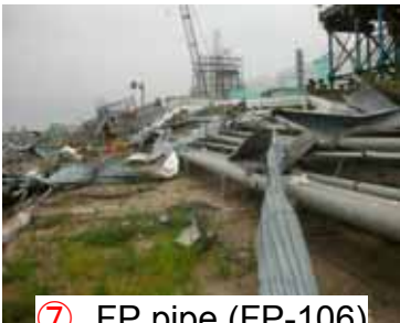
⑦ FP pipe (FP-106)
