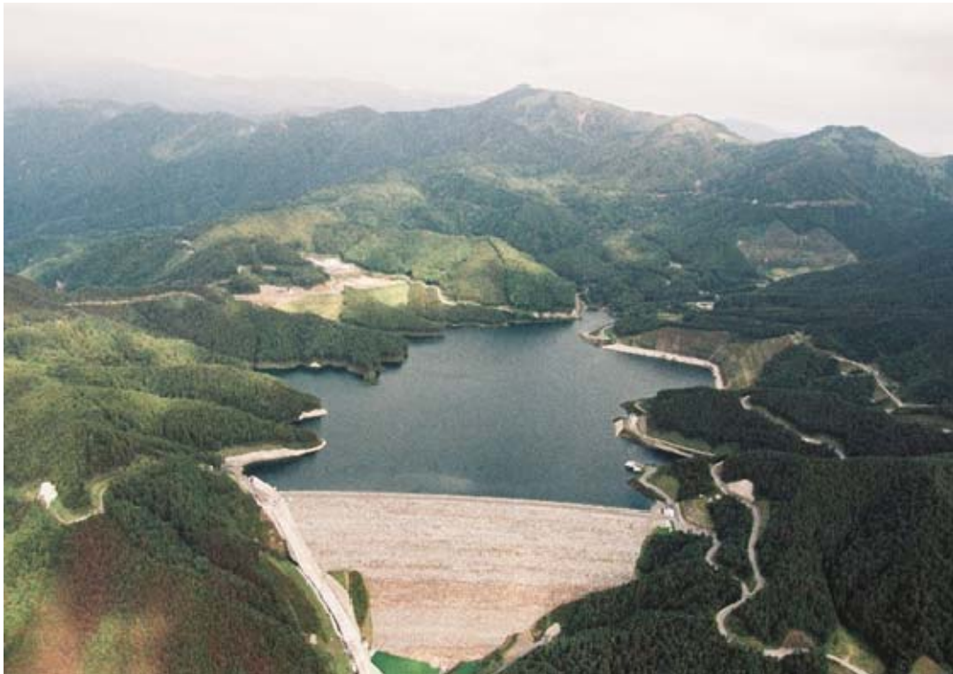
<Upper dam (Kamihikawa dam)>
