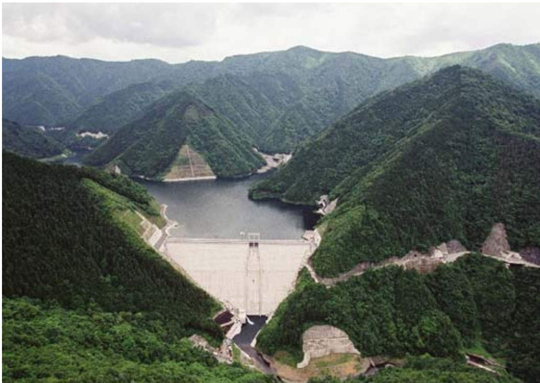
<Lower dam (Kazunogawa dam)>
