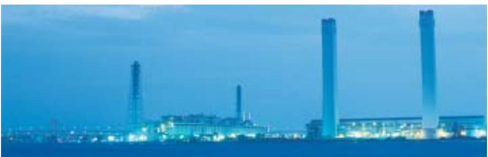
▲ 横浜火力発電所/Yokohama Thermal Power Station
