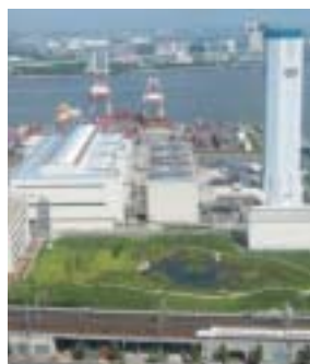
▲ 品川火力発電所 Shinagawa Thermal Power Station
