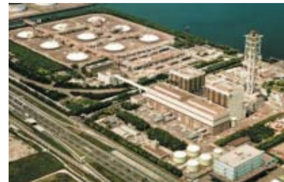
▲ 東扇島火力発電所 / Higashi Ohgishima Thermal Power Station
