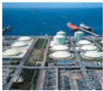
▲ 袖ヶ浦火力発電所の燃料タンク Fuel tanks at the Sodegaura Thermal Power Station
