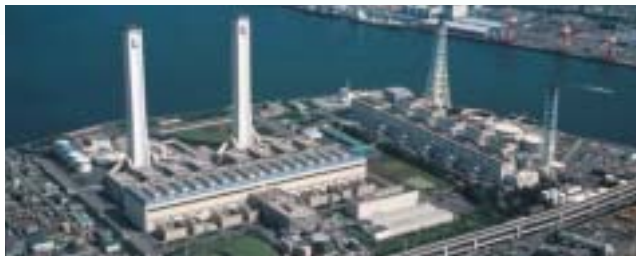
▲ 横浜火力発電所 / Yokohama Thermal Power Station
