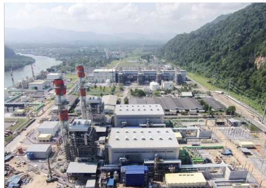
タイカノーム発電所
