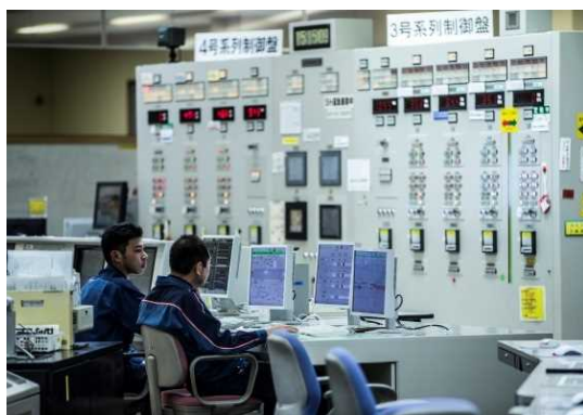
富津火力発電所 中央操作室
