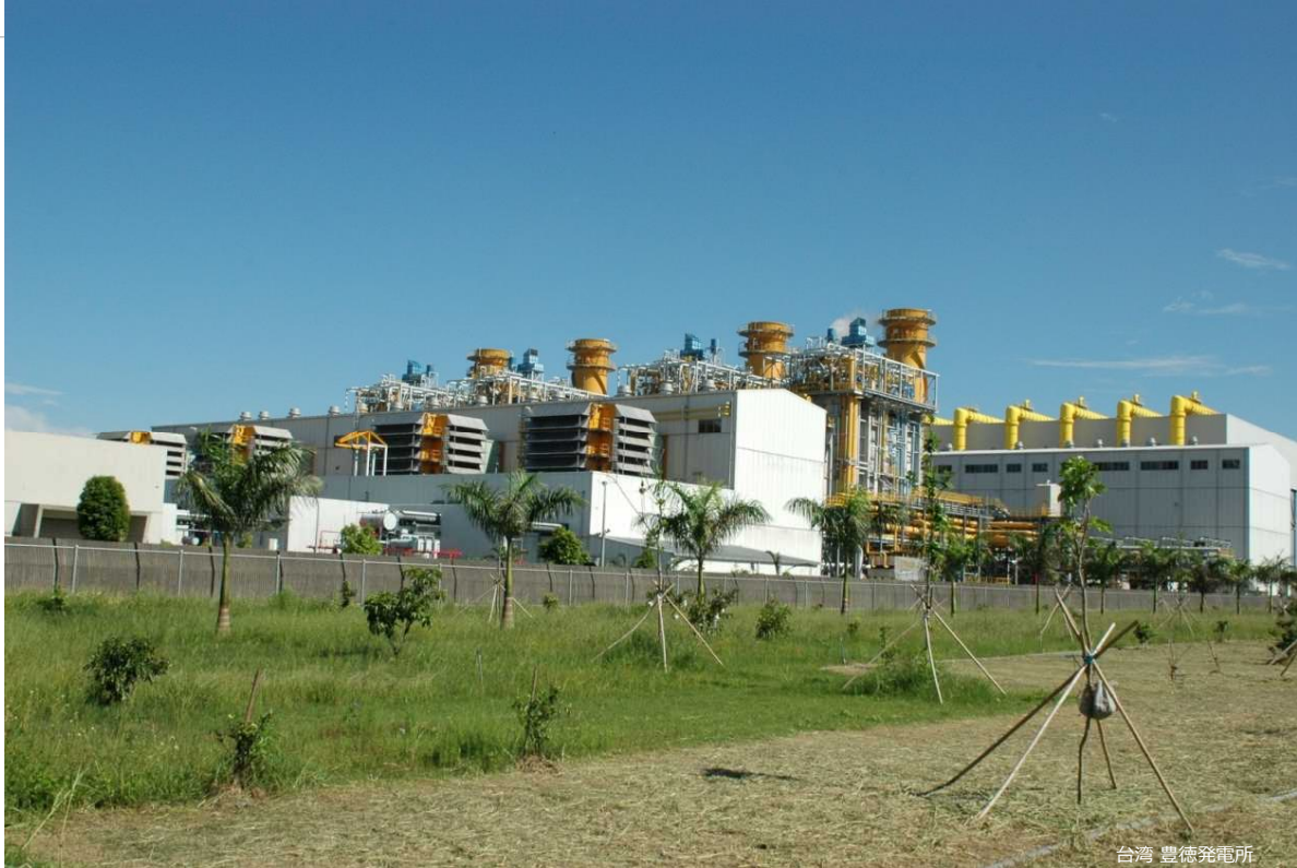
台湾 豊徳発電所
