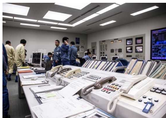
川崎火力発電所 中央操作室
