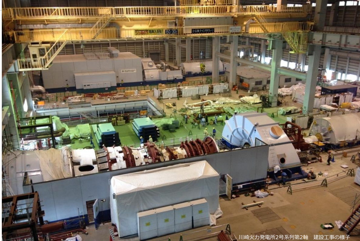
川崎火力発電所2号系列第2軸 建設工事の様子
