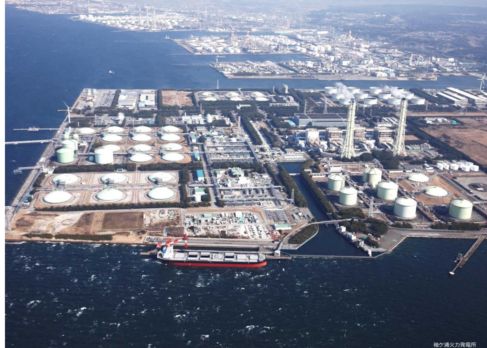
袖ヶ浦火力発電所
