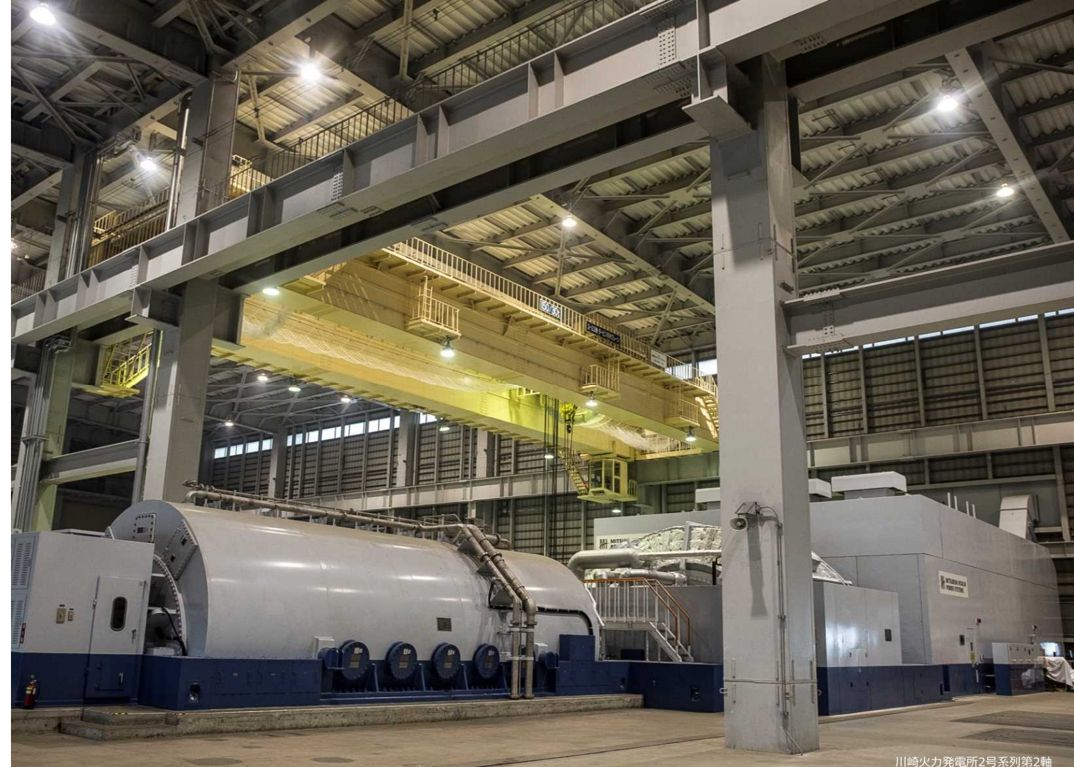
川崎火力発電所2号系列第2軸
