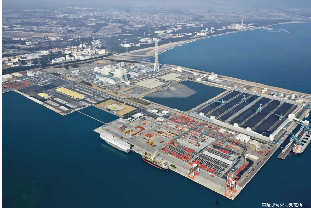
常陸那珂火力発電所
