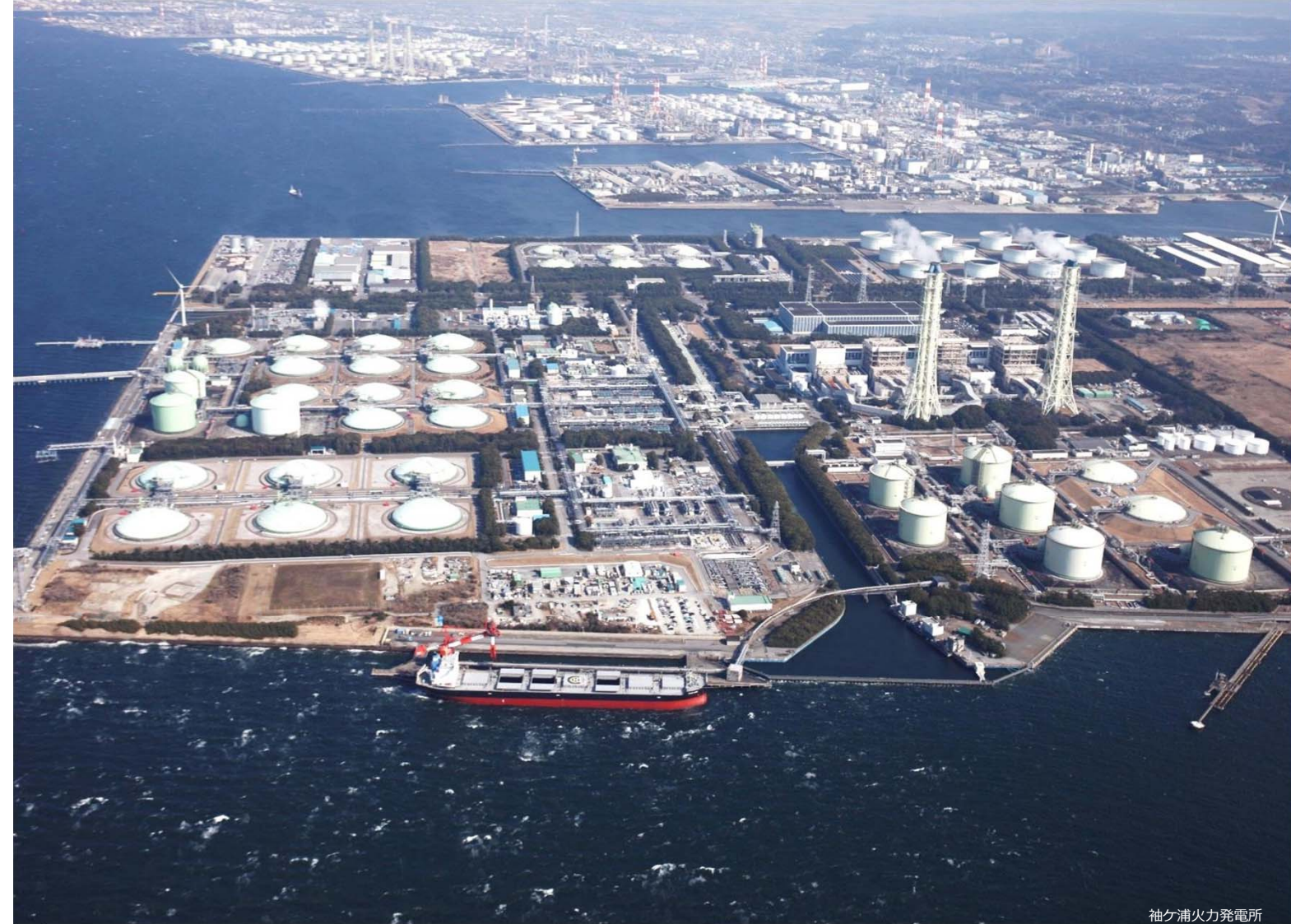
袖ヶ浦火力発電所
