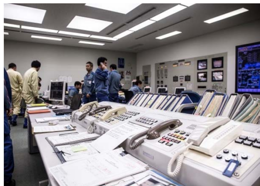
川崎火力発電所 中央操作室
