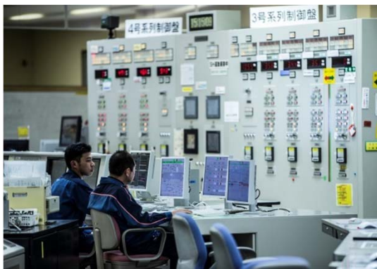
富津火力発電所 中央操作室
