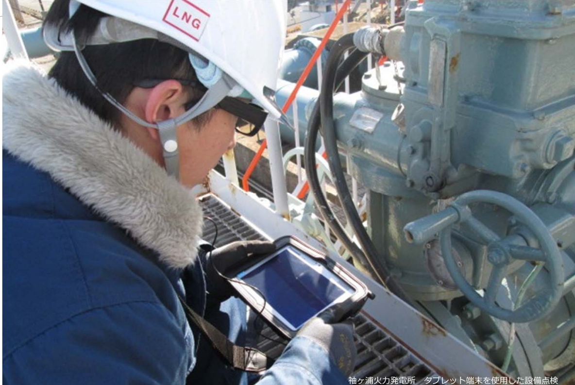
袖ヶ浦火力発電所 タブレット端末を使用した設備点検
