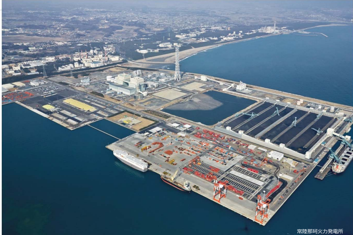
常陸那珂火力発電所
