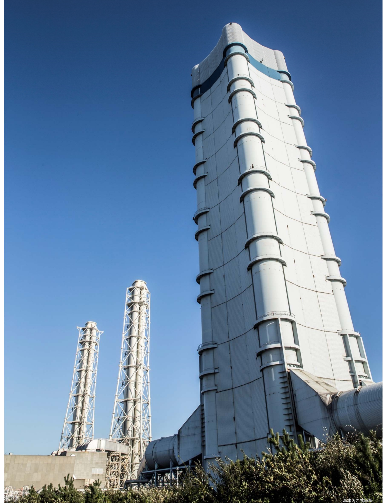
高津火力発電所
