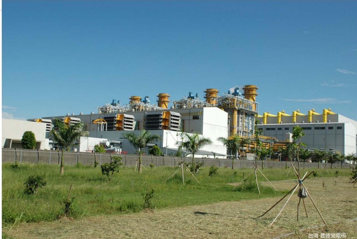
台湾 豊徳発電所
