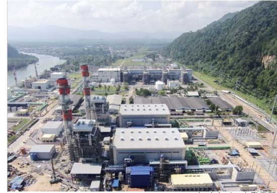
タイカノーム発電所
