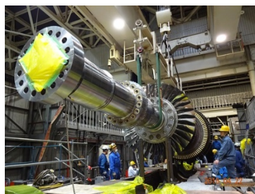
新しいガスタービン設備（ローター）の吊り込み作業
