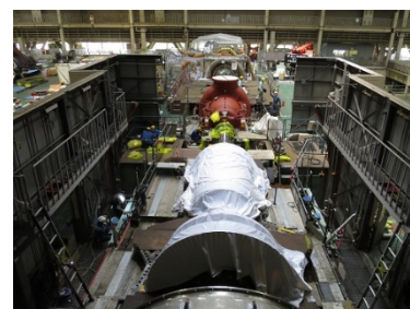
ガスタービン設備分解作業
