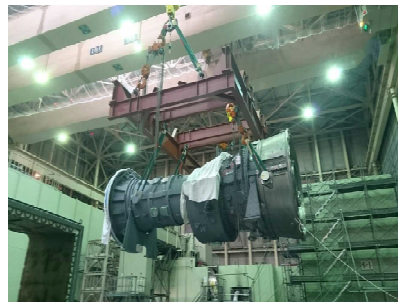
新しいガスタービン車室の吊り込み作業
