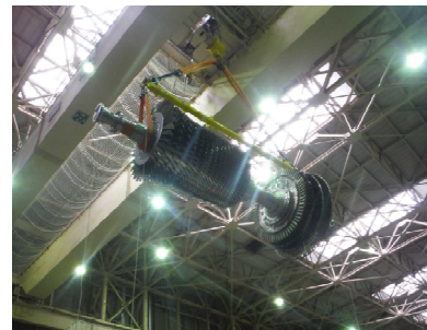
新しいガスタービンローターの吊り込み作業
