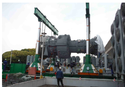
新しいガスタービン車室のタービン建屋への搬入作業
